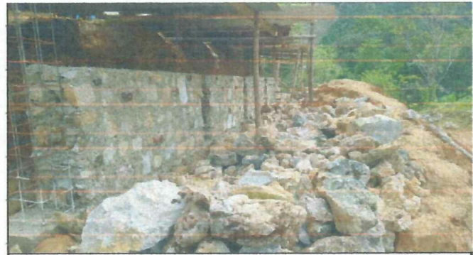
Foto 4: Activación del muro de contención, con un avance del 40%
